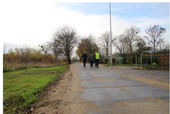
Wykonanie przebudowy ulicy Polnej w Bystrej
