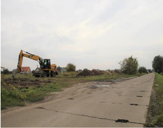
Budowa ulicy Droga Słowackiego w Rokitnicy
