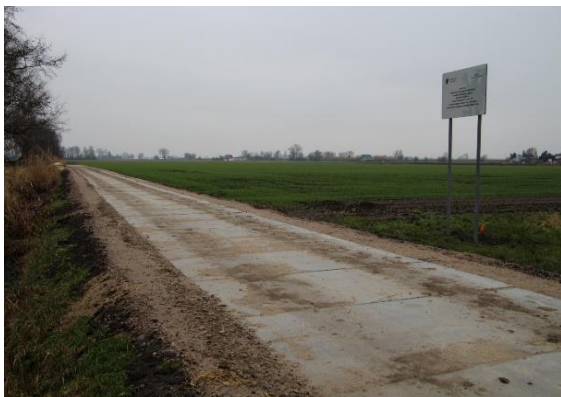
Wykonanie przebudowy drogi gminnej w Krępcu
