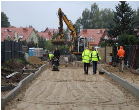
Budowa ulicy Słonecznej (173106G) w Cieplewie
