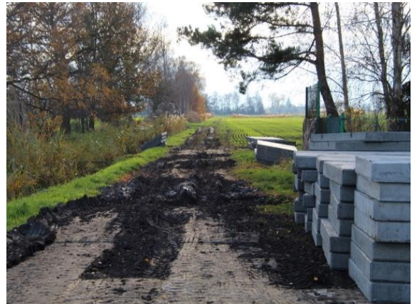
Przebudowa drogi gminnej w Krępcu
