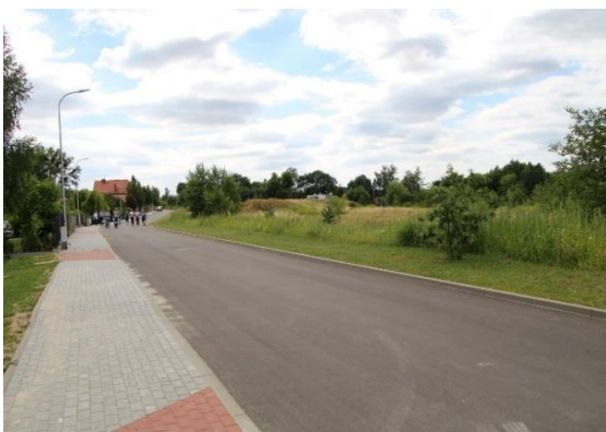
Wybudowanie ulicy Młyńskiej (173678G) w Żukczynie
