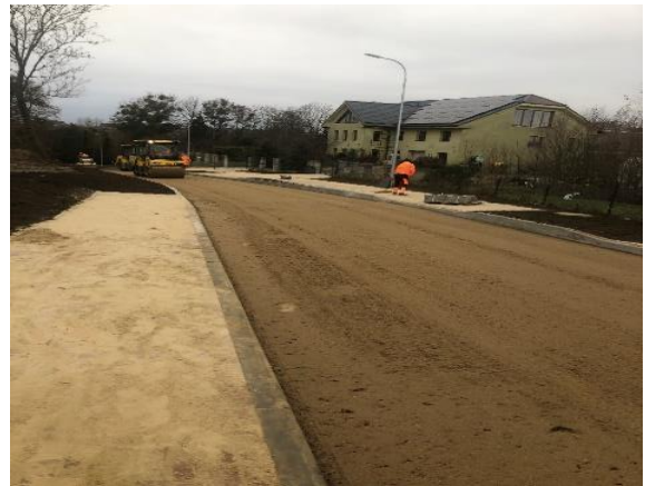
Przebudowa i budowa ulicy Młyńskiej (173678G) w Żukczynie
