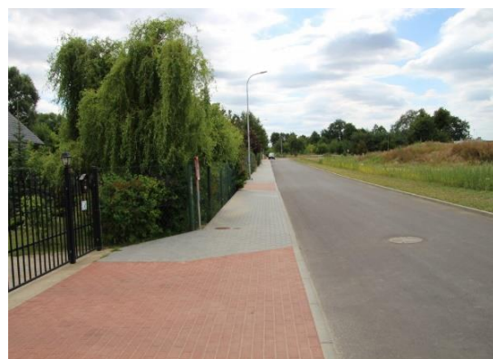
Chodnik przy ulicy Czeremchowej w Żukczynie
