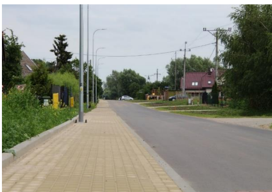
Chodnik przy ulicy Sadowej (173401G) w Rokitnicy
