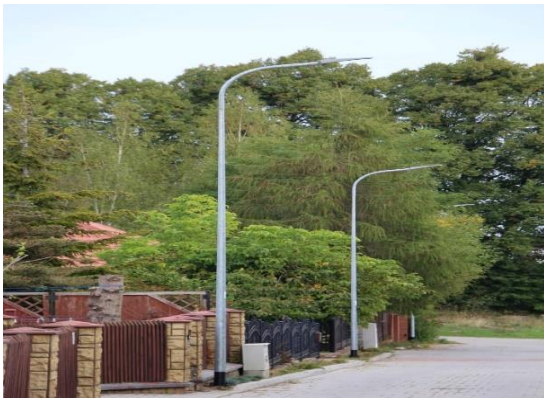
Oświetlenie przy ulicy Dobrej w Juszkwie
