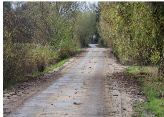
Wykonanie przebudowy ulicy Jesionowej (173566G) w Bystrej
