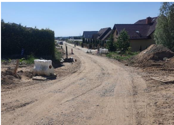
Budowa ulicy Topolowej w Borkowie – etap I
