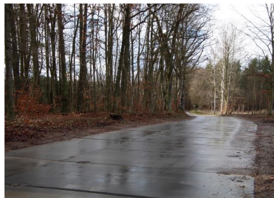
Wykonanie przebudowy ulicy Leśnej (173683G) Żuława – Żuławka
