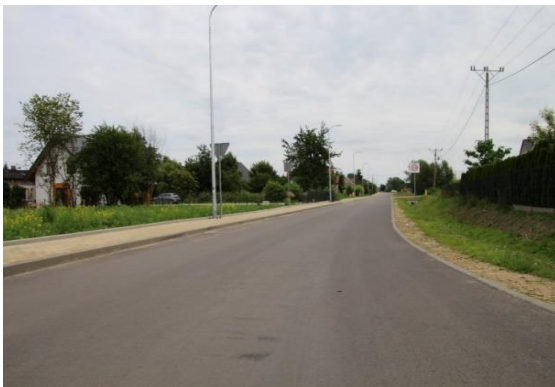
Wykonanie przebudowy ulicy Sadowej (173401G) w Rokitnicy
