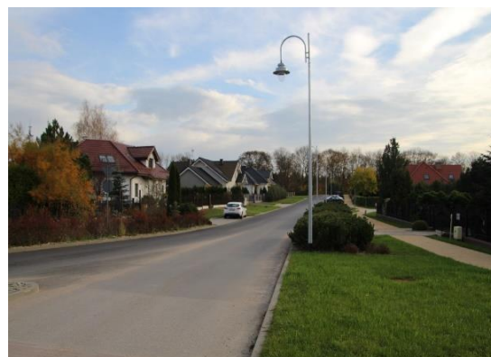
Oświetlenie przy ulicy Neptuna w Straszynie
