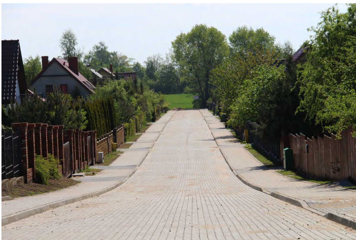
Wybudowanie ulicy Stokrotki w Juszkowie
