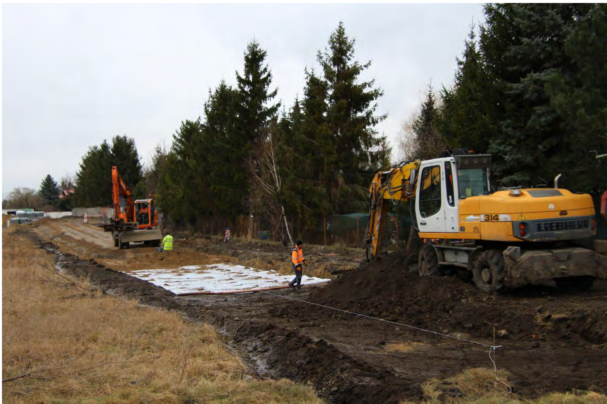
Budowa ulicy Starosty w Łęgowie
