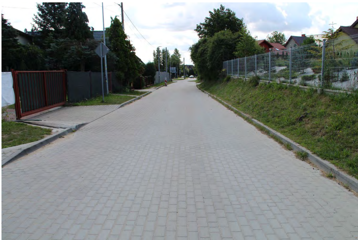
Wybudowanie ulicy Ogrodowej w Juszkowie
