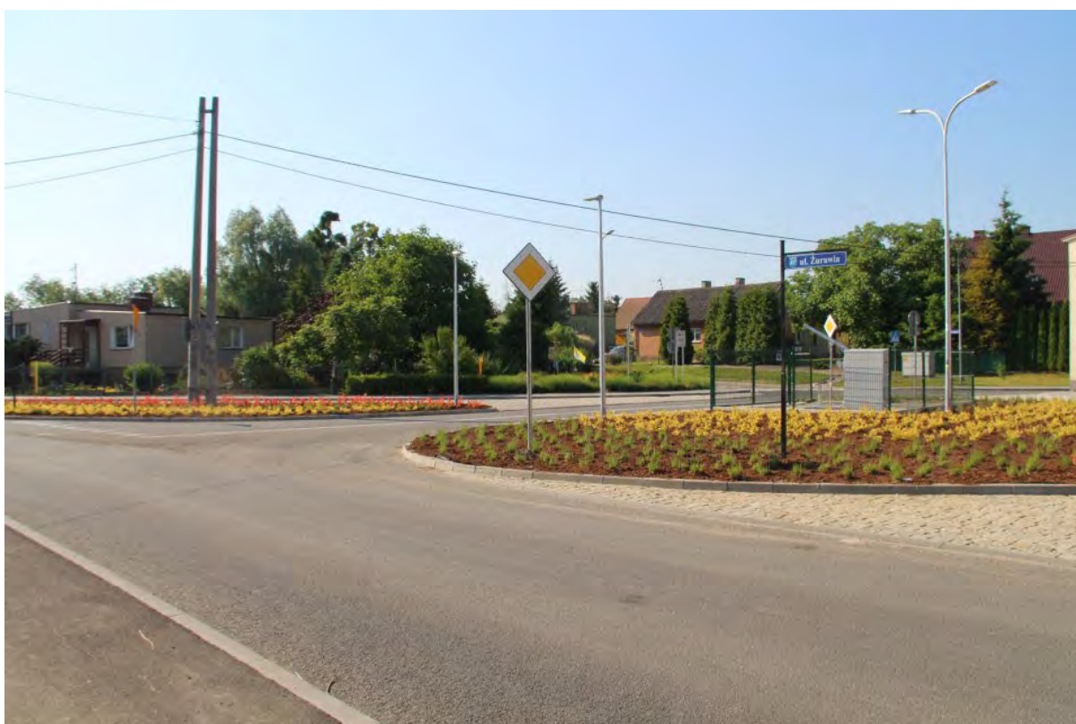
Wybudowanie ulicy Żurawiej w Jagatowie – etap I
