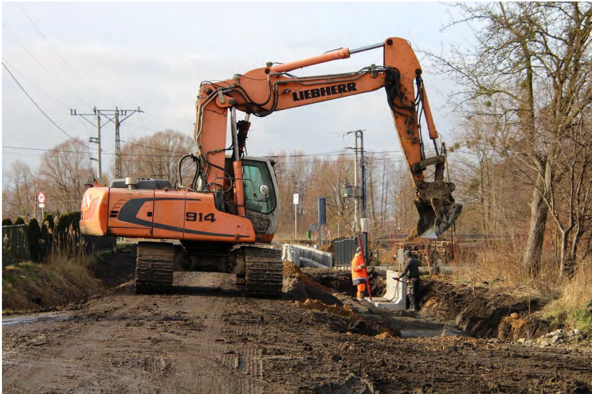
Budowa ulicy Sadowej w Rokitnicy
