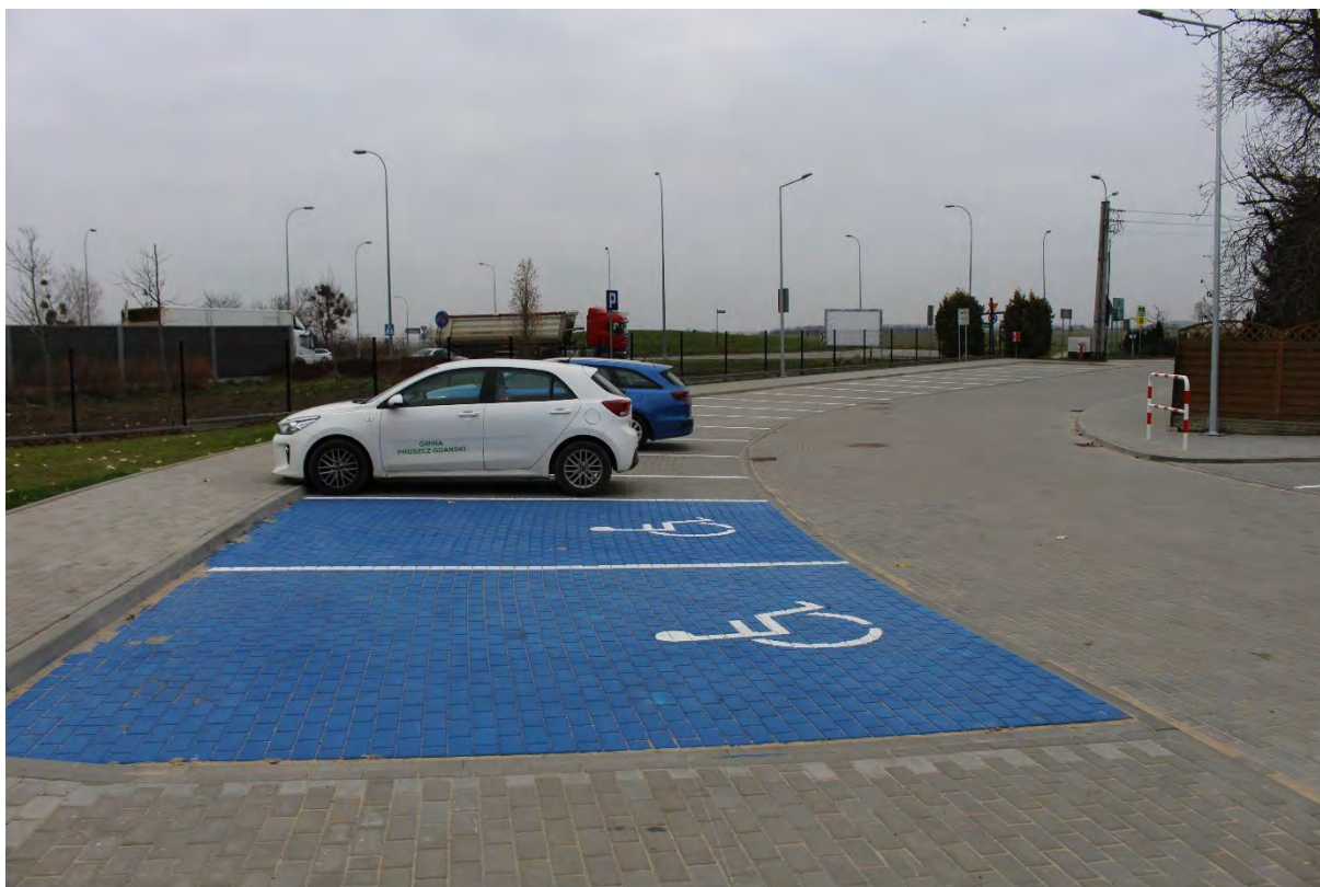
Wybudowanie drogi dojazdowej do szkoły w Wojanowie
