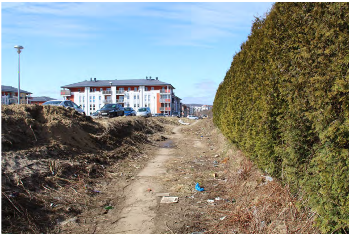
Budowa ulicy Stylowej w Borkowie
