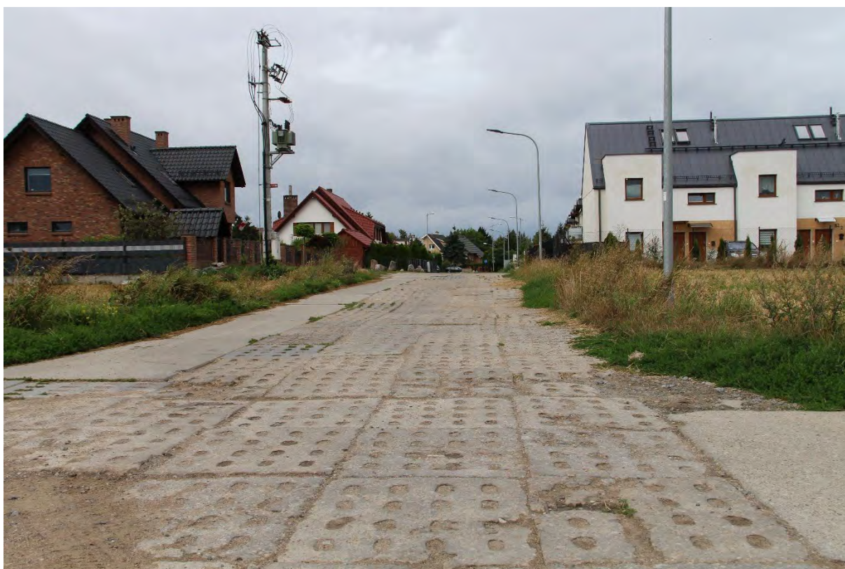
Budowa ulicy Koralowej w Rokitnicy
