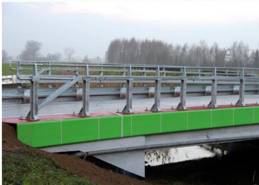
Most w Lędowie (przed i po inwestycji )
